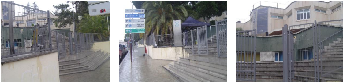
Fig. 7, 8, 9. Exteriores y valla de acceso.
