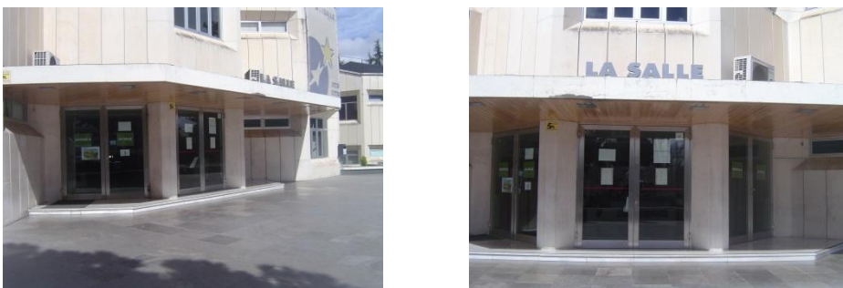
Fig. 10, 11. Acceso frontal calle La Salle 10.
