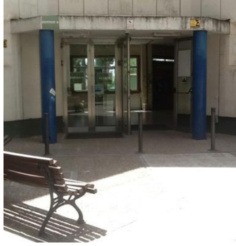
Fig. 24. 25, 26. Hall SiA (accesible). Descenso (accesible) a cafetería y aulas rincón. Puertas exteriores accesibles al/desde el Campus.
